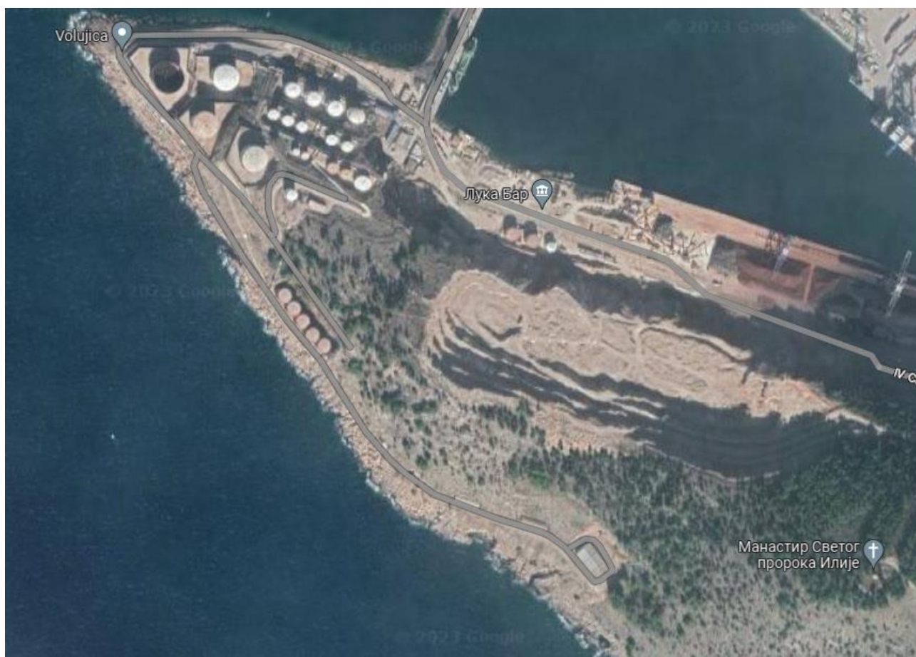
Slika br. 2.4. Rezervoari naftnih derivata i skladište "B" materije na brdu Volujica (Industrijska zona Luke Bar)
